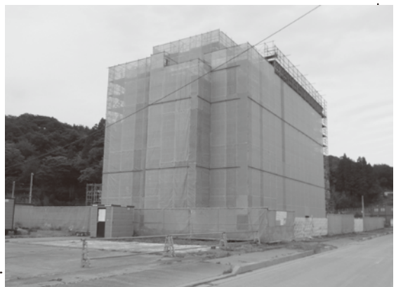
工事中の旧田老観光ホテル 2015年8月30日
