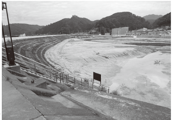
2015年8月30日。防潮堤から見たかさ上げの様子。
