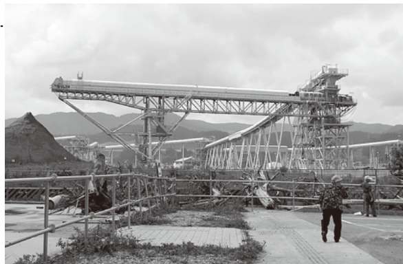
巨大「バルトコンベア」陸前高田市、道の駅「高田松原」の駐車場より。 2015年9月1日撮影。作業を終えて十月半ばより解体が始まったとのこと。
