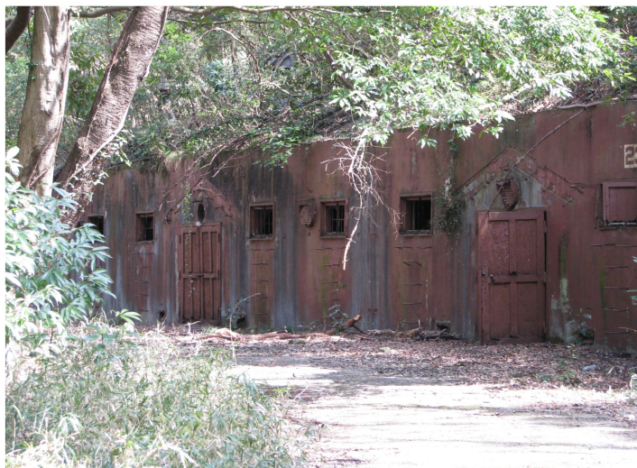
多摩火工廠跡(P)の半地下式倉庫
