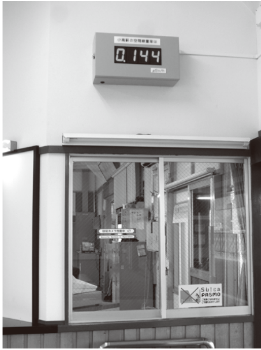
小高駅の改札には、線量計が設置してある。 9月12日撮影。
