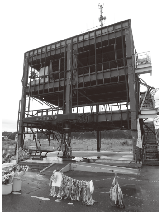
言及したNHKの番組に出てくる、南三陸町の防災対策庁舎。この写真は2013年で、番組に出てくる2012年段階では、正面の柱のところに祭壇があり、もっとそばまで入れた。
